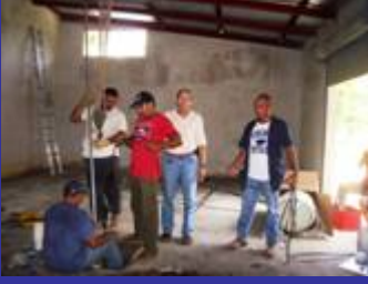
Instalación de la bomba en la bodega nueva
