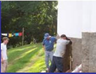
Trabajando en el sistema séptica en la finca
