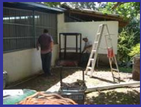
Construction del nuevo torre de agua
