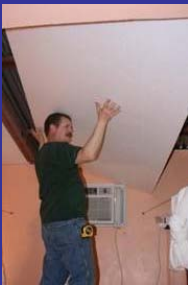
Instalación de formas térmicas en la clínica
