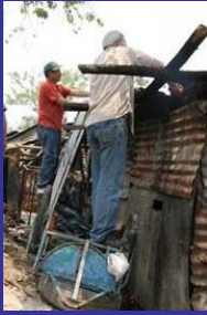
Techo nuevo en Los Laureles
